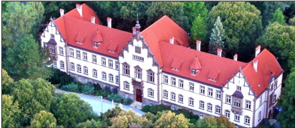
Die Stadt Warstein ist Standort zweier Krankenhäuser: das allgemeine Krankenhaus Maria-Hilf sowie die LWL-Klinik für Psychiatrie und Psychotherapie Warstein. Beide Häuser sind über Warstein hinaus bekannt und wurden in den vergangenen Jahren partiell ausgebaut. Der LWL-Klinik Warstein ist das LWL-Institut Warstein mit seinen beiden Bereichen medizinische Rehabilitation psychisch kranker Menschen und medizinisch-berufliche Rehabilitation psychisch kranker Menschen administrativ verbunden.
