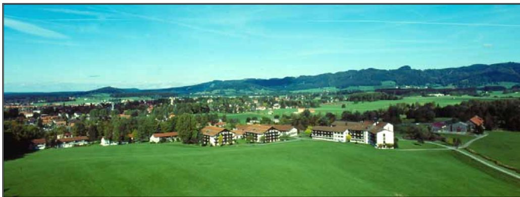
Am Südrand des heilklimatischen Kurorts Isny, mitten im grünen Allgäu, ist auf einem weiten, parkartigen Gelände das Stephanuswerk angesiedelt. Zu allen größeren Städten in der Umgebung besteht eine regelmäßige Busverbindung.
